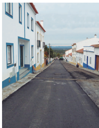
Substituição de pavimento com implantação de Rede de Esgotos Pluviais, reparação da rede de abastecimento de águas, na rua de S. Geraldo, em Alcáçovas
