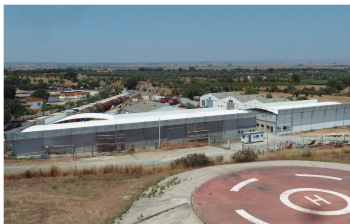
Empreitada de Remodelação do Estaleiro Municipal de Viana do Alentejo
