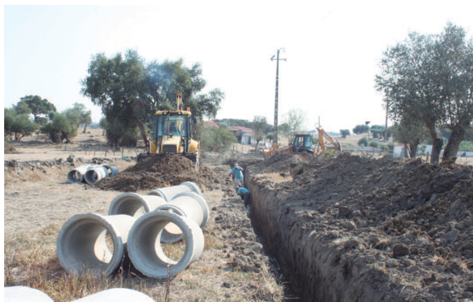
Montagem de coletor de águas pluviais numa extensão de 100m, em Aguiar
