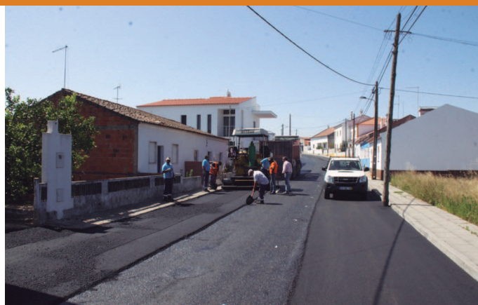
Trabalhos de asfaltamento no Bairro dos Barrancões, em Alcáçovas
