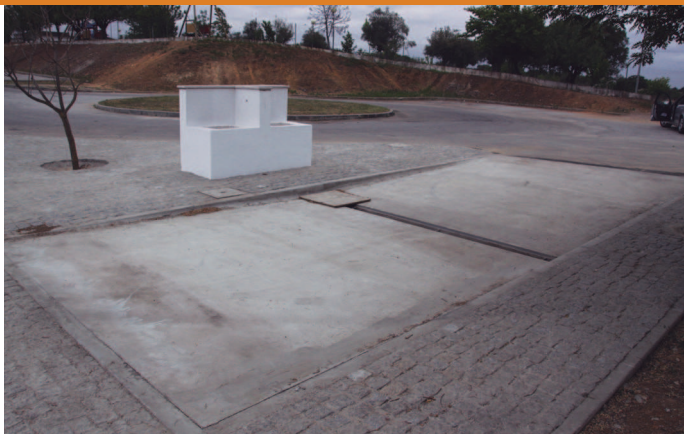
Construção de área de serviço para autocaravanas, na Quinta da Joana, junto ao circuito de manutenção, em Viana do Alentejo
