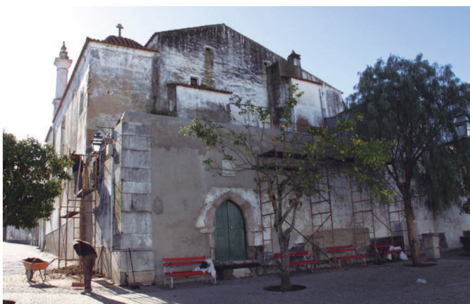
Trabalhos de reboco em paredes e pintura exterior do Paço dos Henriques em Alcáçovas e manutenção e pintura de portas
