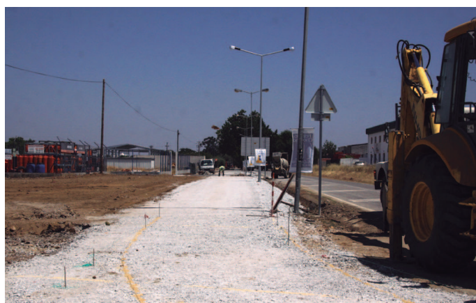
Construção de um passeio da Rotunda da Zona Industrial ao Cemitério de Viana do Alentejo
