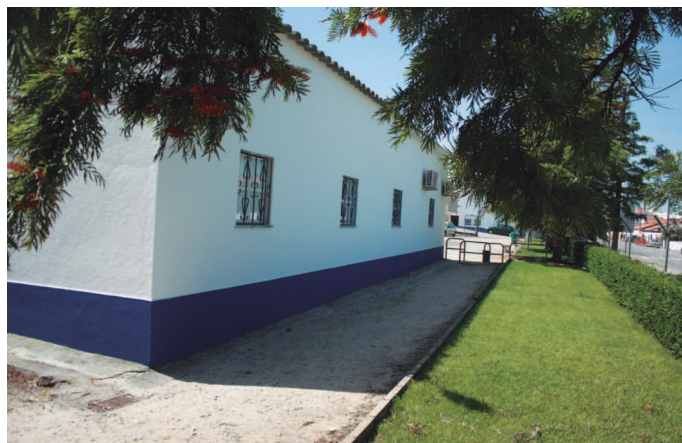
Impermeabilização, pintura e colocação de algerozes no edifício da antiga Cooperativa, em Aguiar
