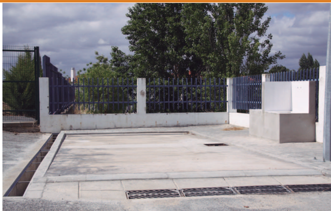
Construção de área de serviço para autocaravanas, entre o Pavilhão Municipal e a Sede da Cruz Vermelha, em Alcáçovas
