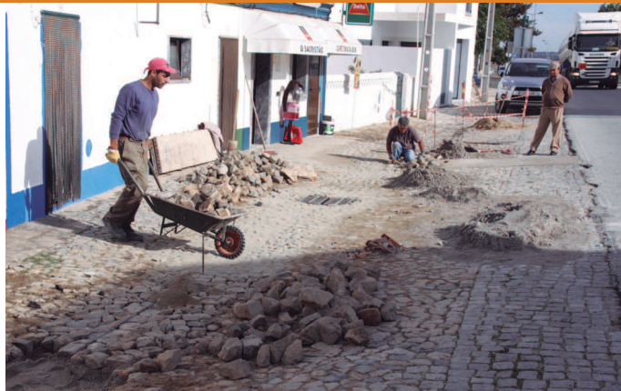
Montagem de coletor de águas pluviais e melhoramento da calçada, na rua 25 de Abril, em Aguiar
