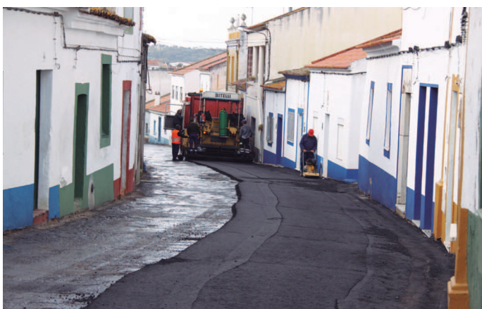
Trabalhos de asfaltamento na rua de Alcácer, em Alcáçovas, tendo sido previamente executadas reparações nas redes de águas e esgotos
