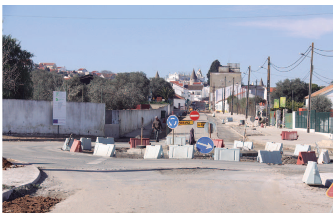
Evolução das obras de requalificação urbanística à entrada de Viana, no sentido de Portel, com a criação de rotunda, passeios e lugares de estacionamento, colocação de sinalização vertical e horizontal, iluminação pública e repavimentação
