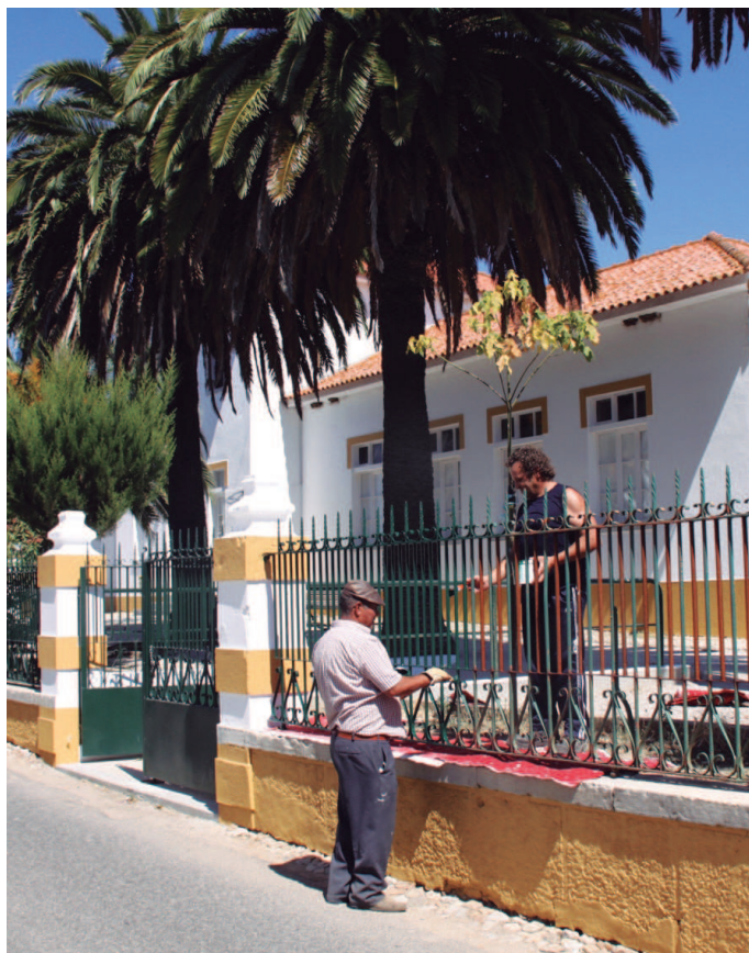
Obras de remodelação e pintura na Escola de S. João, em Viana do Alentejo
