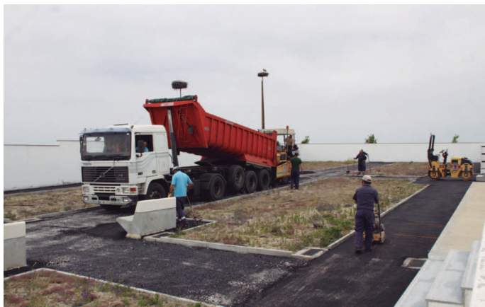
Trabalhos de asfaltamento na parte ampliada do cemitério de Aguiar
