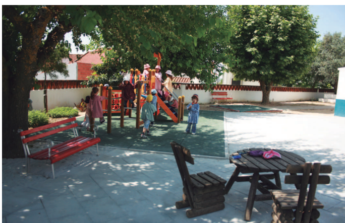
Pavimentação no recinto do receio e colocação de novo parque infantil no jardim-de-infância de Aguiar
