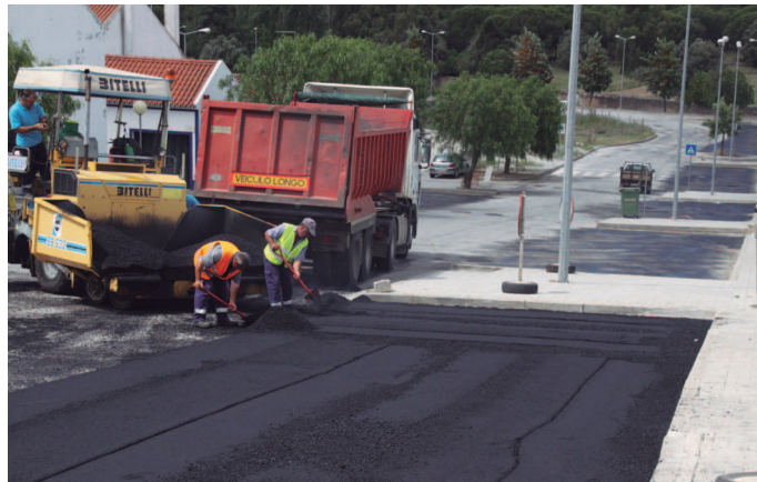
Trabalhos de asfaltamento nas ruas do Bairro do Chão do Mocho, em Alcáçovas
