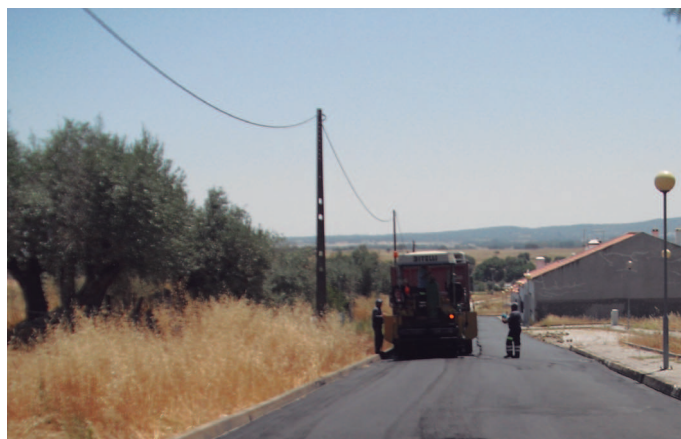
Asfaltamento em Aguiar, Rua Antiga
