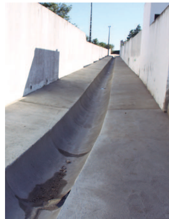
Revestimento em betão armado da vala junto ao campo da bola em Aguiar
