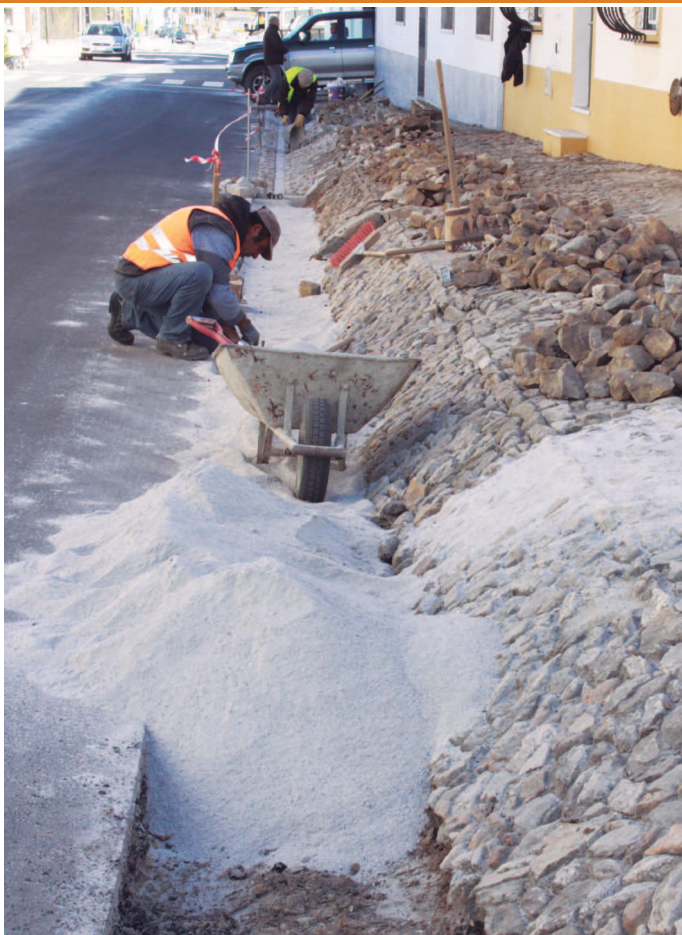
Reparação da calçada do passeio em frente aos “Moinhos de S. António”, em Viana do Alentejo
