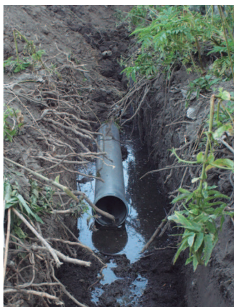
Execução de troço de rede de esgotos em Viana do Alentejo
