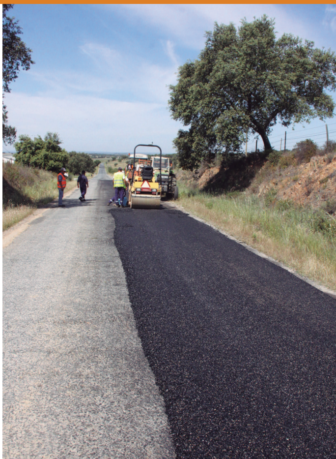
Trabalhos de asfaltamento e melhoramento da estrada de S. Catarina, que liga Alcáçovas ao concelho de Alcácer do Sal, num troço de cerca de 6,5 km, dentro da área geográfica do Concelho de Viana do Alentejo
