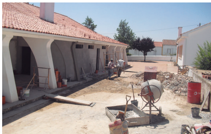
Segunda fase da obra de requalificação da EB1 de Aguiar, com a construção de novos sanitários e pintura de muros
