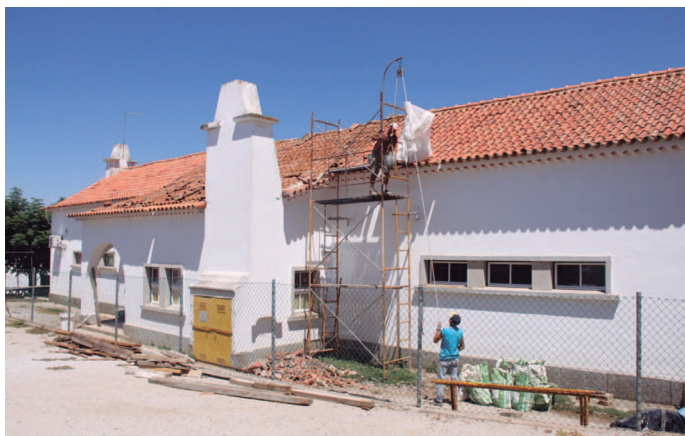
Jardim-de-infância de Viana (Cantina): levantamento do telhado, com substituição de algerozes, vigas, ripas e telhas danificadas.
