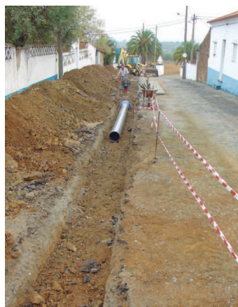
Substituição de pavimento com implantação de Rede de Esgotos Pluviais, reparação da rede de abastecimento de águas, na rua de S. Geraldo, em Alcáçovas
