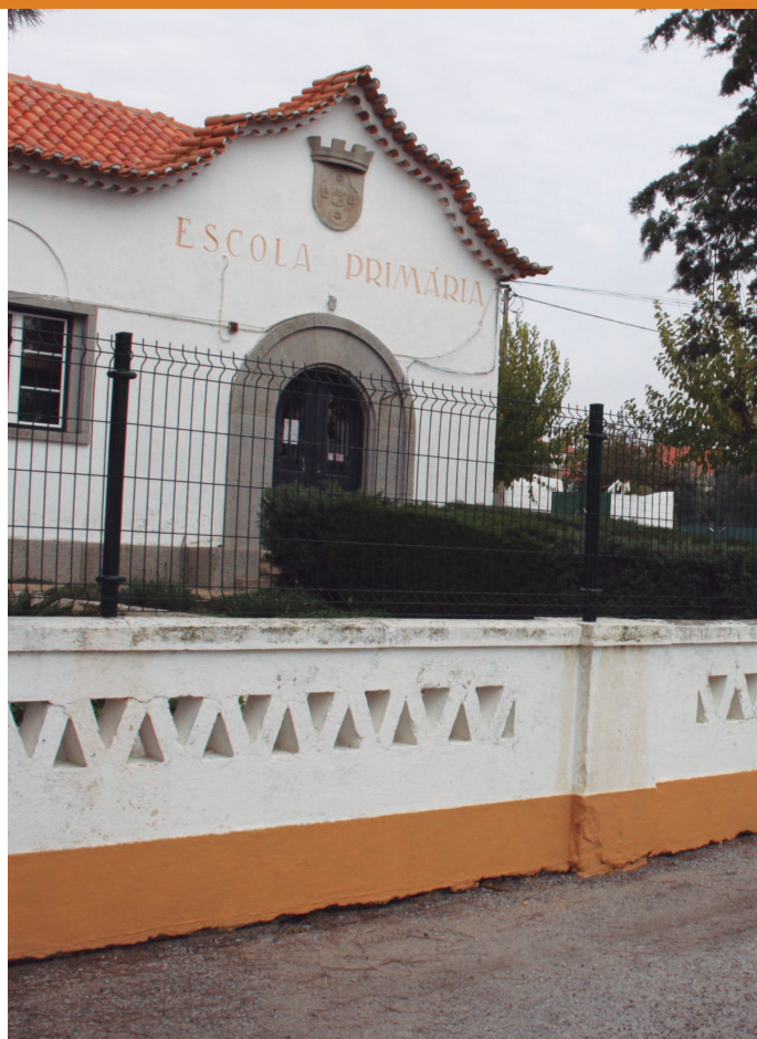
Arranjos exteriores com a colocação de uma vedação, arranjos no telhado e melhoria do sistema de escoamento de água da chuva no pátio de recreio da EB1 de Aguiar
