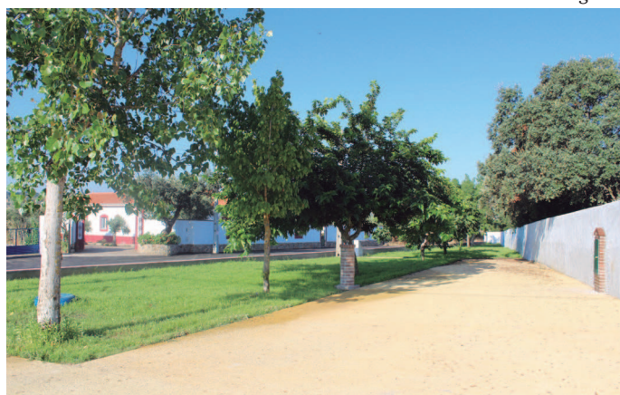
Conclusão do Parque de Merendas do Chão dos Courinhos, em Alcáçovas
