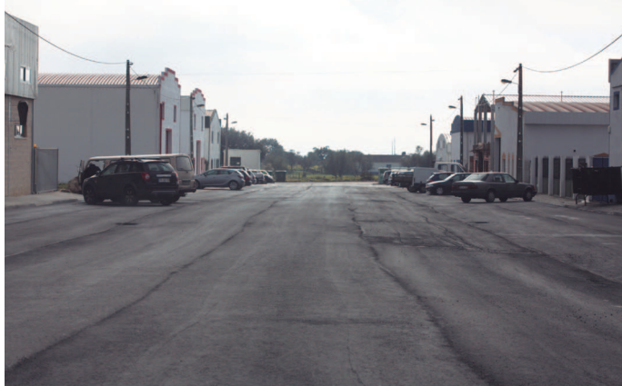
Trabalhos de asfaltamento nas ruas da Zona Industrial de Alcáçovas
