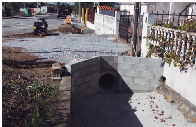
Melhoramento das drenagens à saída para Santa Catarina
