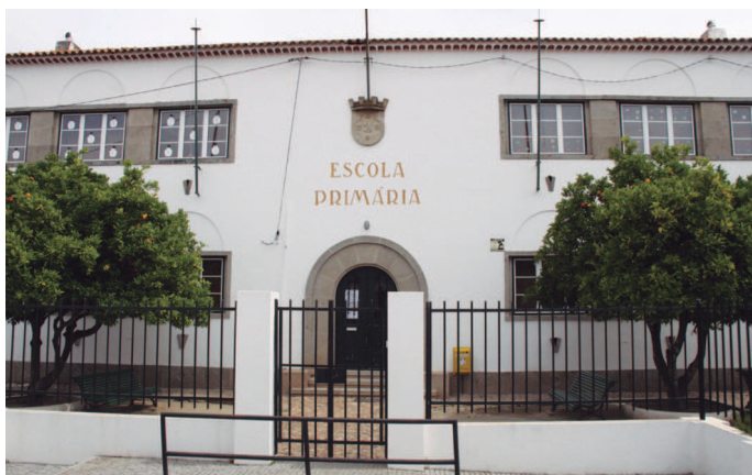
Obras de remodelação e pintura na Escola das Escadinhas, em Viana do Alentejo
