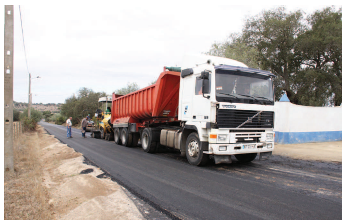
Pavimentação da estrada que liga o Bairro dos Barrancões à EN2, em Alcáçovas, na saída para o Torrão, numa extensão de 1.2 km.
