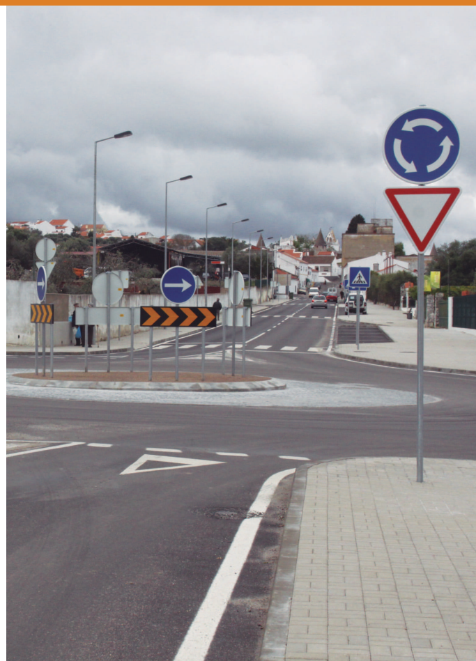
Evolução das obras de requalificação urbanística à entrada de Viana, no sentido de Portel, com a criação de rotunda, passeios e lugares de estacionamento, colocação de sinalização vertical e horizontal, iluminação pública e repavimentação
