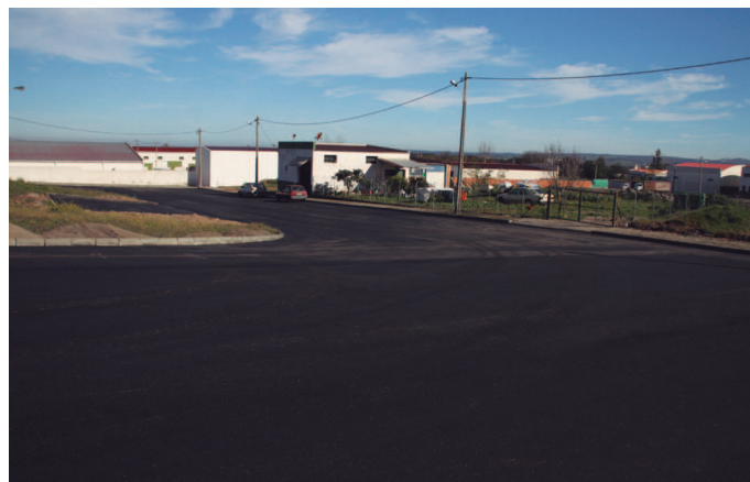
Trabalhos de asfaltamento nas ruas da Zona Industrial de Viana do Alentejo (ZIVA)
