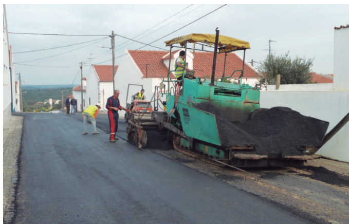
Substituição de pavimento, na rua 8 de Março, em Alcáçovas
