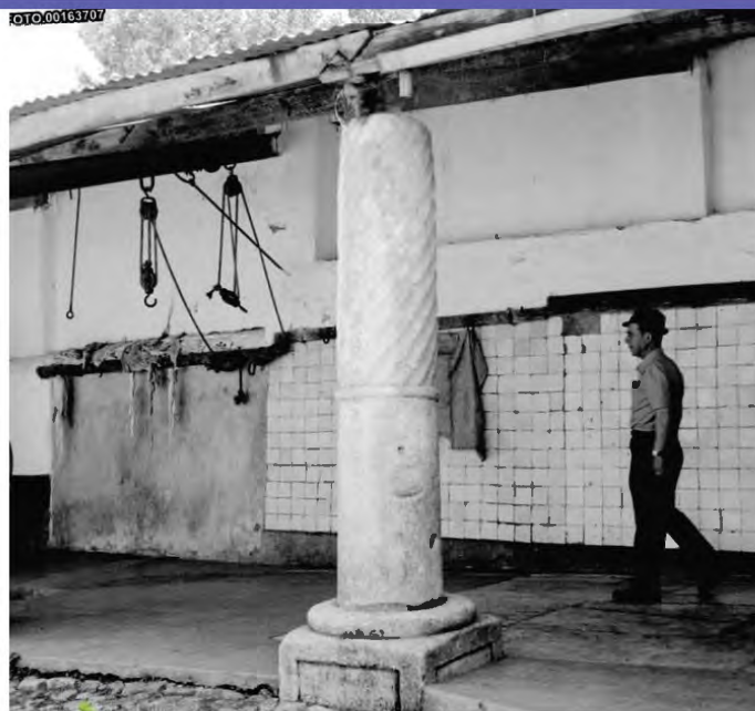
Figura 1 - A coluna do pelourinho ainda no Matadouro Municipal, servindo de suporte ao telheiro. Em segundo plano o então fiscal do mercado, Nói Nunes [Fotografia da DGEMN, 1975].
